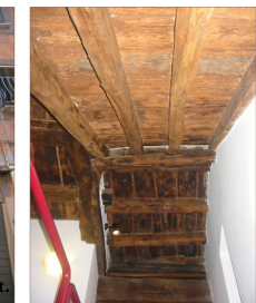
struttura della scala che porta al p. II
