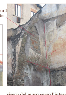
risega del muro verso l'interno testimonia che l'unità finiva qui
