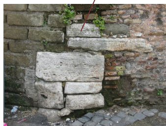
Base pilastro in blocchi di travertino
